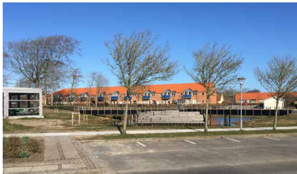
Anlægget i Hurup - klimatilpasningsprojekt med scenetrappe og ophold i søen
